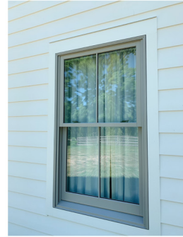
Exterior WC 2.jpg
