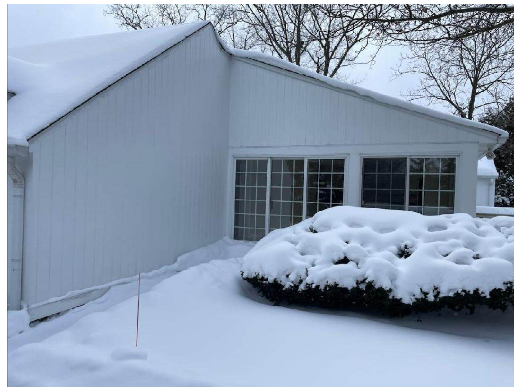
existing house - rear n.e. corner
